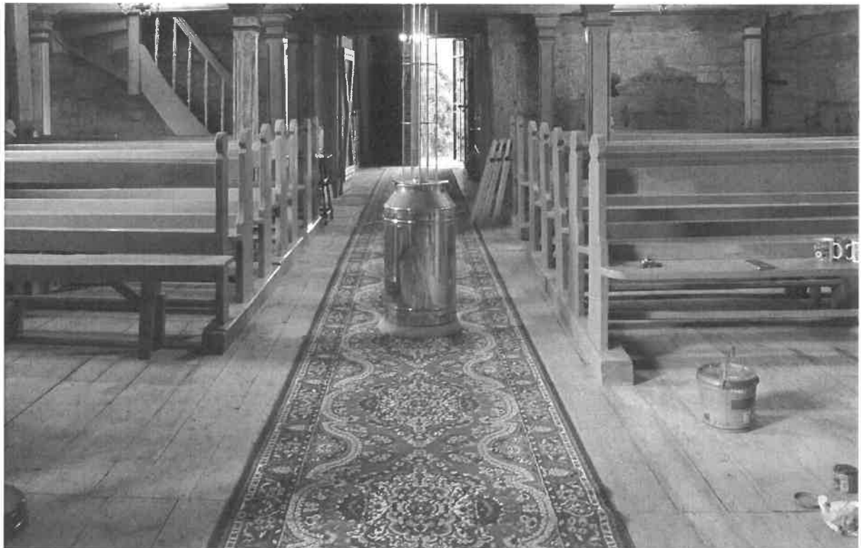
Fot. nr 5 i 6 Kościół w Szczodrowie. Współczesna drewniana podłoga z desek sosnowych. Widok na prezbiterium i nawę. Fot. E. Przebirowska, 2020r.
