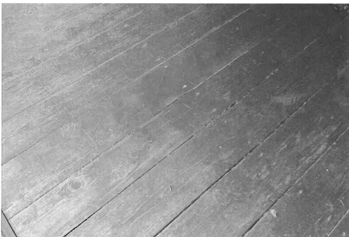
Fot. nr 11 i 12 Kościół w Szczodrowie. Współczesna drewniana podłoga z desek sosnowych w kruchcie. Podłoga kilka lat temu została pomalowana. Fot. E. Przebirowska 2020r.
