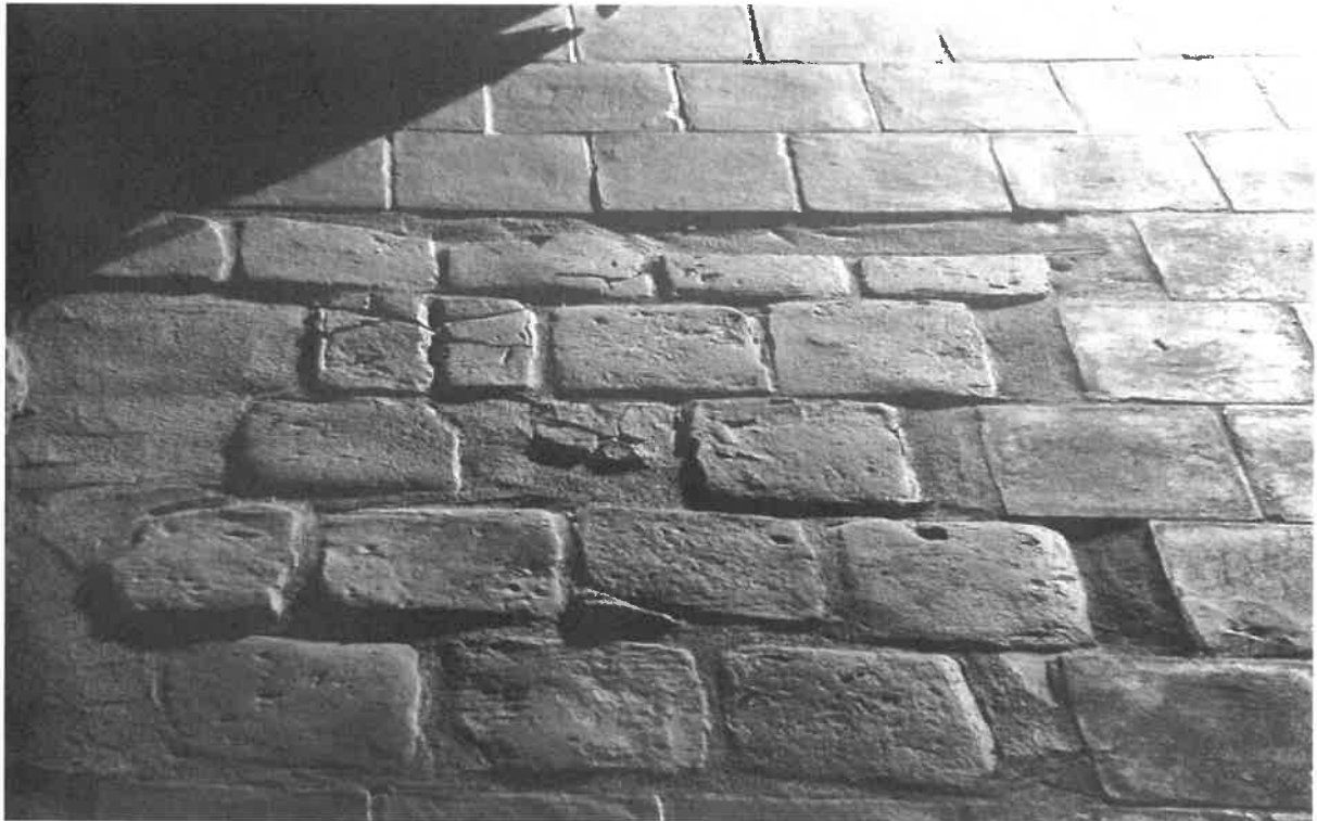
Fot. nr 21 Kościół w Kosieczynie. Fragment posadzki ceramicznej oryginalnej gotyckiej i zrekonstruowanej. Fot. z publikacji przyp. pr 3 – publikacja internet.
