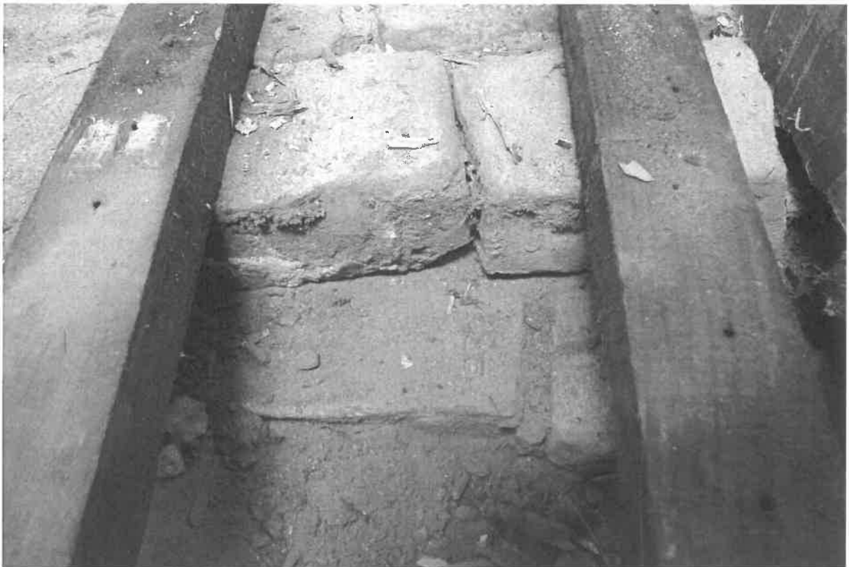
Fot. nr 13 i 14 Kościół w Szczodrowie. Odkrywka w nawie- pod deskami legary, wylewka betonowa, warstwy cegieł. Na górnej fotografii widoczny fundament kamienny. Fot. E. Przebirowska 2020r.
